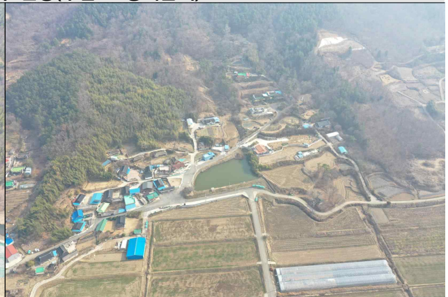
③ 시범사업대상지 남측 전경
